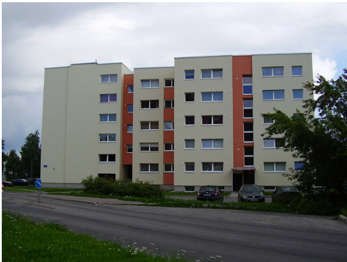
Joonis 4.15. 5-korruseline telliselamu
