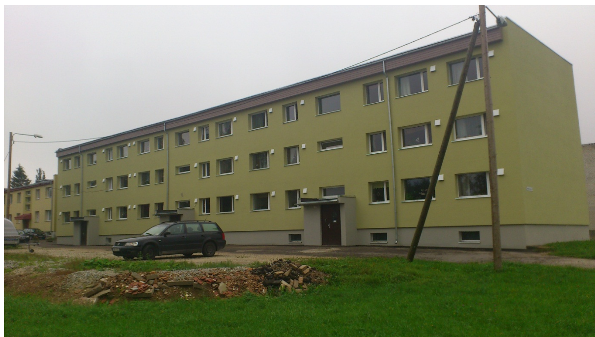
Joonis 4.23. 3-korruseline telliselamu
